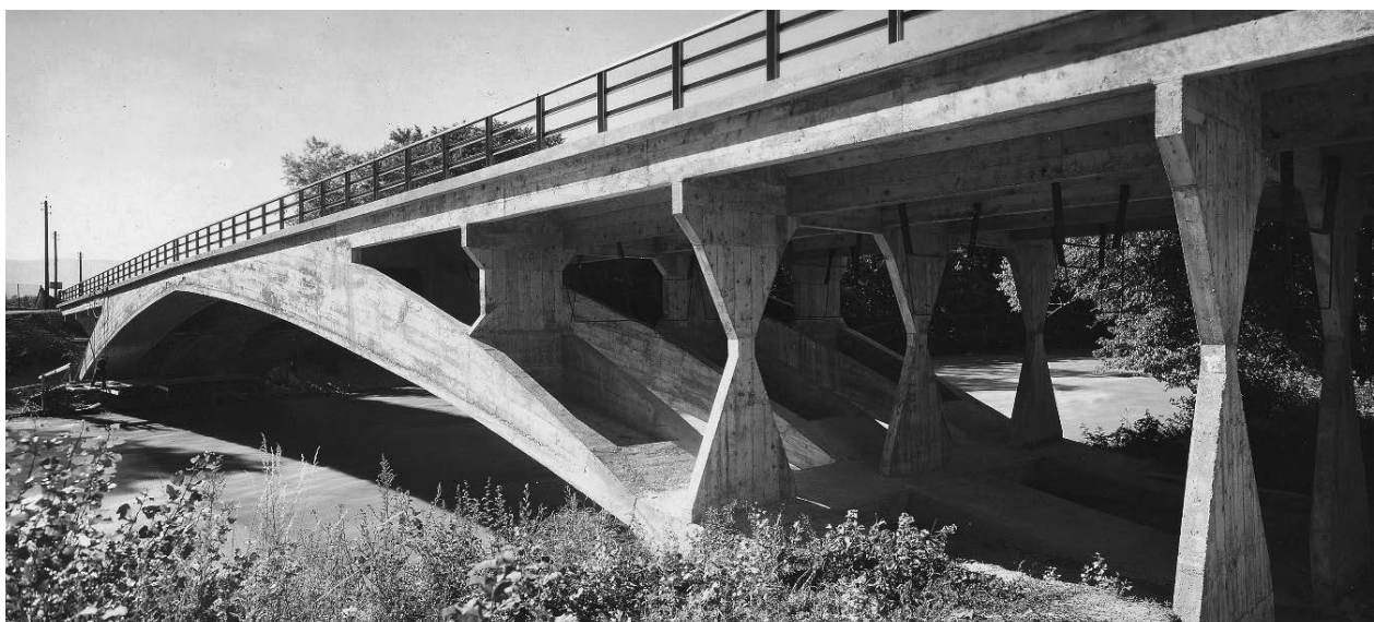
Abb. 5: Zwei von Robert Maillart entworfene Brücken mit dem markanten Dreigelenksystem: Die Tavanasa-Brücke über den Rhein (oben) und die Brücke über die Arve bei Vessy, die durch die auffällig eingekerbten Stützen die Formkraft des Brückenkünstlers verdeutlicht (unten © ETH Bibliothek Zürich).
