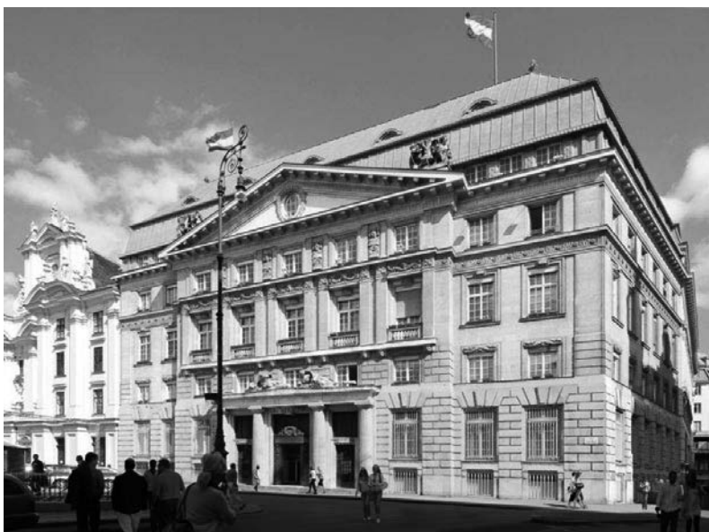
Abb. 5: Das Gebäude „Am Hof“ vor dem Umbau
