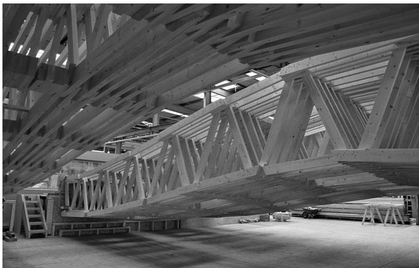
Abb. 2: Das sequentielle Dach der ETH Zürich, geplant mit BIM, gebaut mit dem größten Portalroboter Europas (Quelle: www.espazium.ch )
