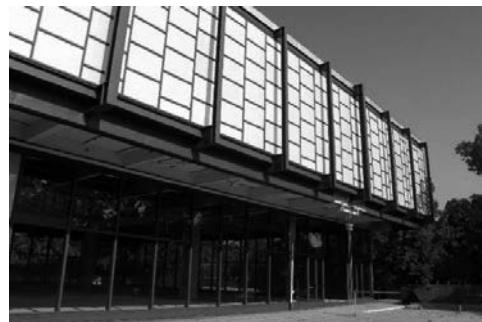
Abb. 1: Das „21er Haus“, eine noch immer in Nutzung stehende Stahlkonstruktion von 1958 [Foto Zeman & Co GmbH]
