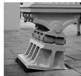
Abb. 2 Stützenfuß der „historischen“ Konstruktion des HBF Salzburg, gedreht in die Wirkungsline der Auflagerkraft
