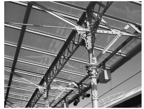
Abb. 4: Gußeisenstütze am Hauptbahnhof Salzburg [Foto Zeman & Co GmbH]
