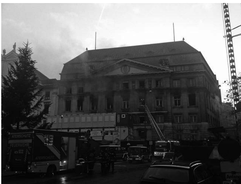
Abb. 6. Großbrand „Am Hof“: 18.11.2011
