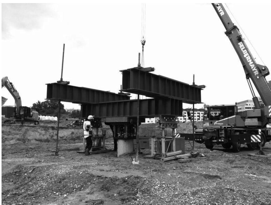
Abb. 3 - Anordnung statische Pfahlprobelastung
