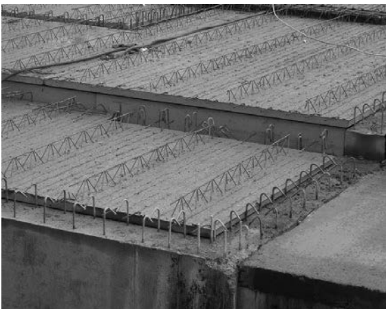
Abb. 4: Elementdecke vor dem Aufbringen des Ortbetons (Foto: Potucek)
