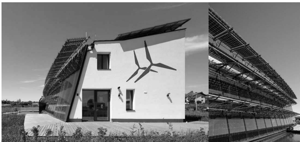
Abb. 4: Photovoltaikanlage, PV-Elemente auf dem Dach und vor der Südfassade
