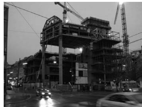
Abb. 12: Die Traggeschoße eines Hochhauses aus Stahl in 1020 Wien während der Montage
