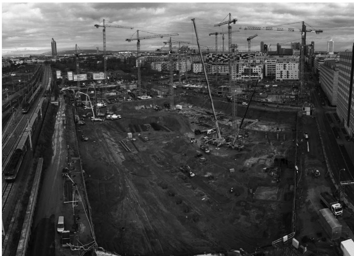
Abb. 4 – Baufelder 5, 6, 7, 8 und 39.2 (November 2015)
