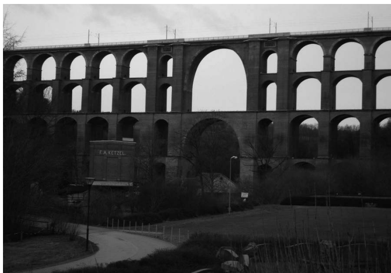
Foto 8: Eisenbahnbrücke - Göltzschtalbrücke, größte Ziegelsteinbrücke der Welt (1848) 78m hoch, Deutschland (Foto: H. Brezinschek)
