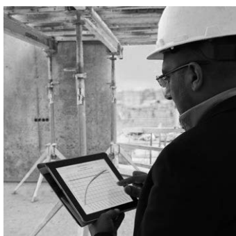
Abb. 3: Das Tablet am Bau für die Überwachung von Echtzeitereignissen wie die Eigenschaften eines Frischbetons (Quelle: www.gulfconstructiononline.com )
