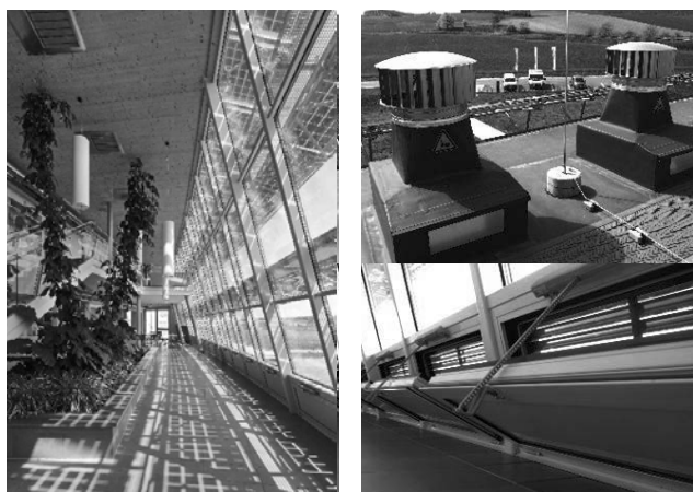
Abb. 2: Südliche Glaswand (links), Lüftungsklappen im Fußbodenbereich (rechts unten), Windgeneratoren (rechts oben)
