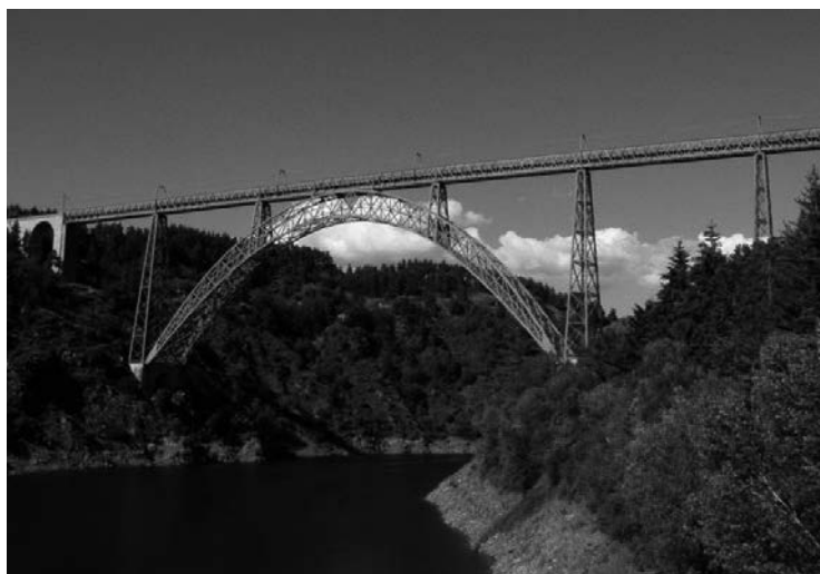
Abb. 1 Garabit Viadukt, Frankreich (erbaut 1880 - 1884)
