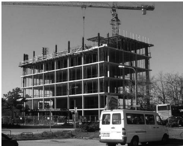
Abb. 5: Herstellung eines Bürohauses mit Flachdecken (Foto Potucek)
