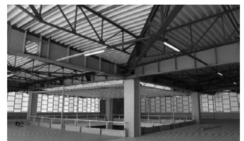
Abb. 8: geschraubte und geschweißte Konstruktion aus der Mitte des 20. Jhdts [Foto Zeman & Co GmbH]
