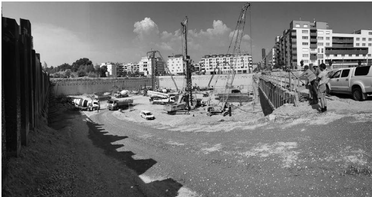
Abb. 2 - Bohrfahrarbeiten Baufeld 8 im Schutz der Schlitz- und Spundwandumschließung
