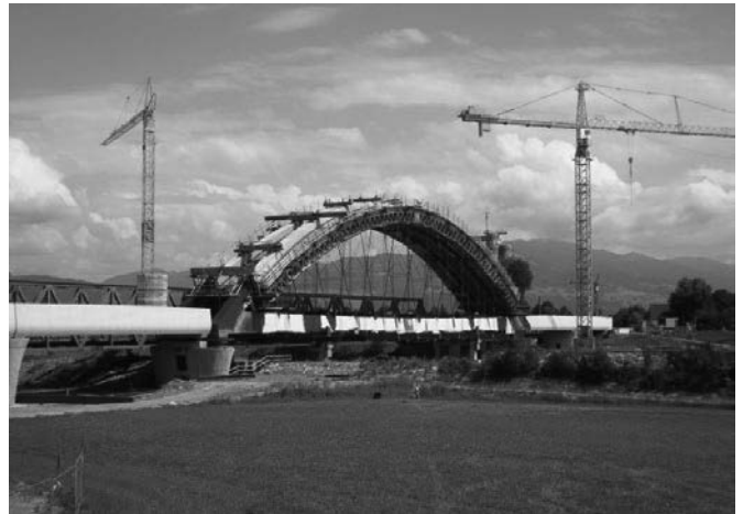
Abb. 2 Rheinbrücke Lustenau, Österreich (erbaut 2010 - 2012)
