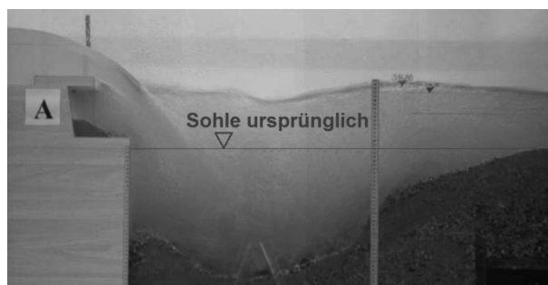
Abb. 3: Zu kurzes Tosbecken
