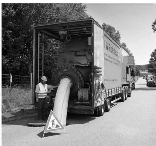
Abb. 3.: Sanierungsfahrzeug im Einsatz.
