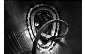
Abb. 4.: Wickeleinheit in einem Eiprofil
