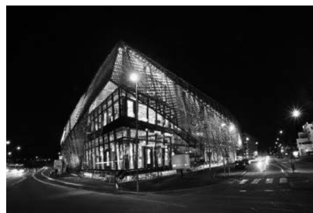
Abb. 10: schlanke Strukturen aus Stahl in Kombination mit Aluminium [Foto Rudolf Leiner GmbH]
