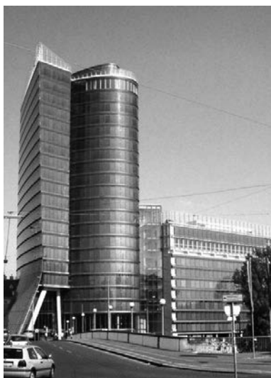
Abb. 6: Bürogebäude mit Glasfassade, Wien
